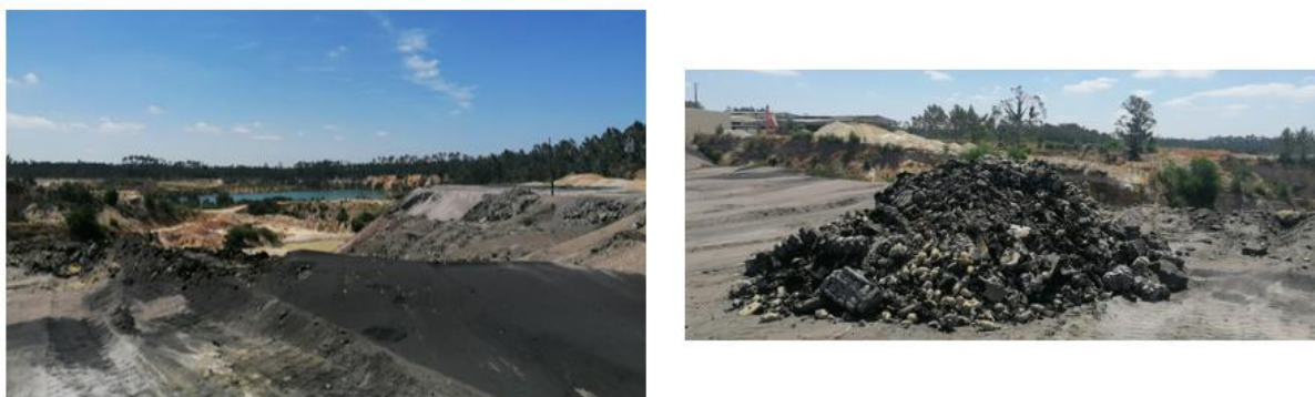
Figura 10 – Enchimento de vazios com inertes. Fonte: visita 22-07-2026
